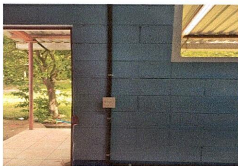
Foto 5: Reparación de instalaciones electricas, cableado distribuido a tomas de corriente y circuitos de iluminación.
