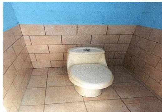
Foto 2: Sustitución de sanitarios, por sanitarios lavables, accesorios y conexiones.
