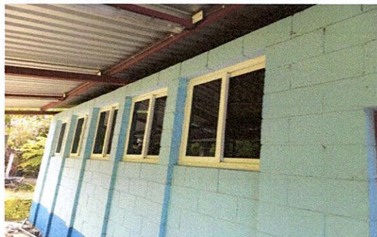
Foto1: Sustitución de ventanas; sistema de apertura: corredizas, perfiles color blanco estandar, Material del marco: PVC material de la ventana: vidrio, sellado perimetral.
