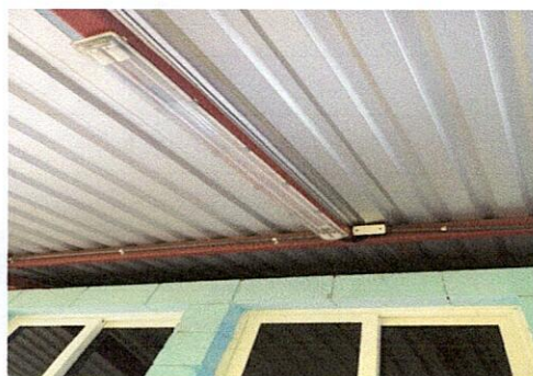
Foto 3: Sustitución de sistemas de iluminación: lámparas por lámparas tipo de Led.
