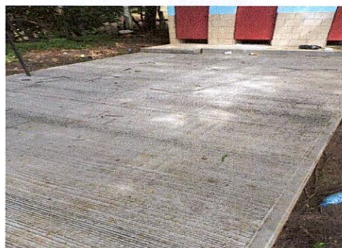
Foto 4: Reparación de losa de concreto para patio, considerando preparación de terreno, armado, nivelación y acabado rústico
